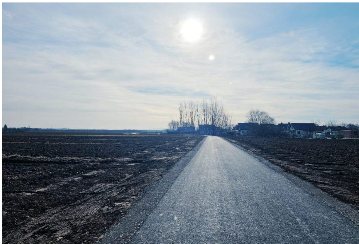
„Remont drogi gminnej 202483K w km od 0+425 do 0+729 w miejscowości Bobrowniki Małe, gmina Wierzchosławice”
