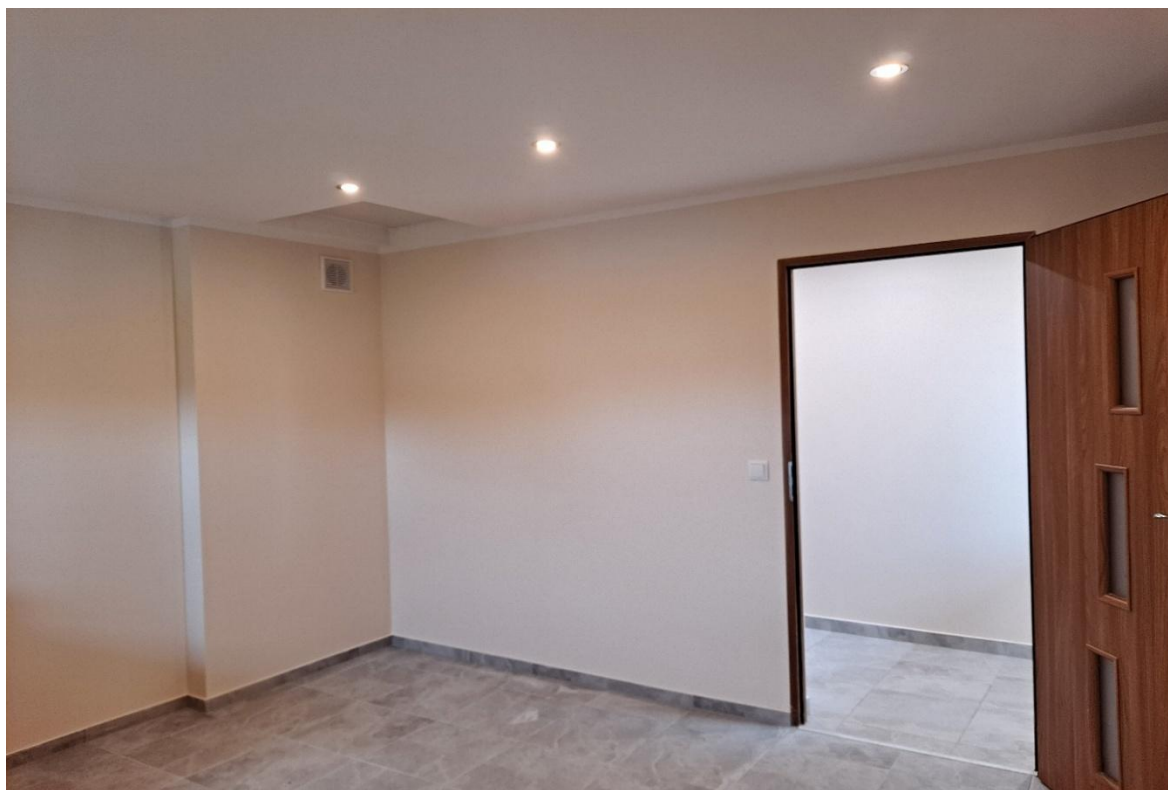
„Remont świetlicy wiejskiej w miejscowości Rudka”
