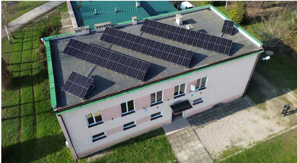
Budowa instalacji fotowoltaicznej zlokalizowanej na dachu budynku Domu Ludowego w Bobrownikach Małych
