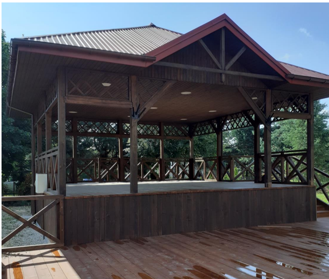
Modernizacja sceny plenerowej w Wierzchoławicach
